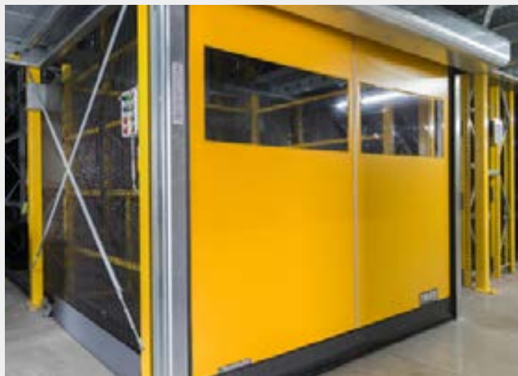
Omer Mono 10 → 2 monte-charges 1000 kg ▲ Avec portes automatiques pourvues de serrures de sécurité ▶
